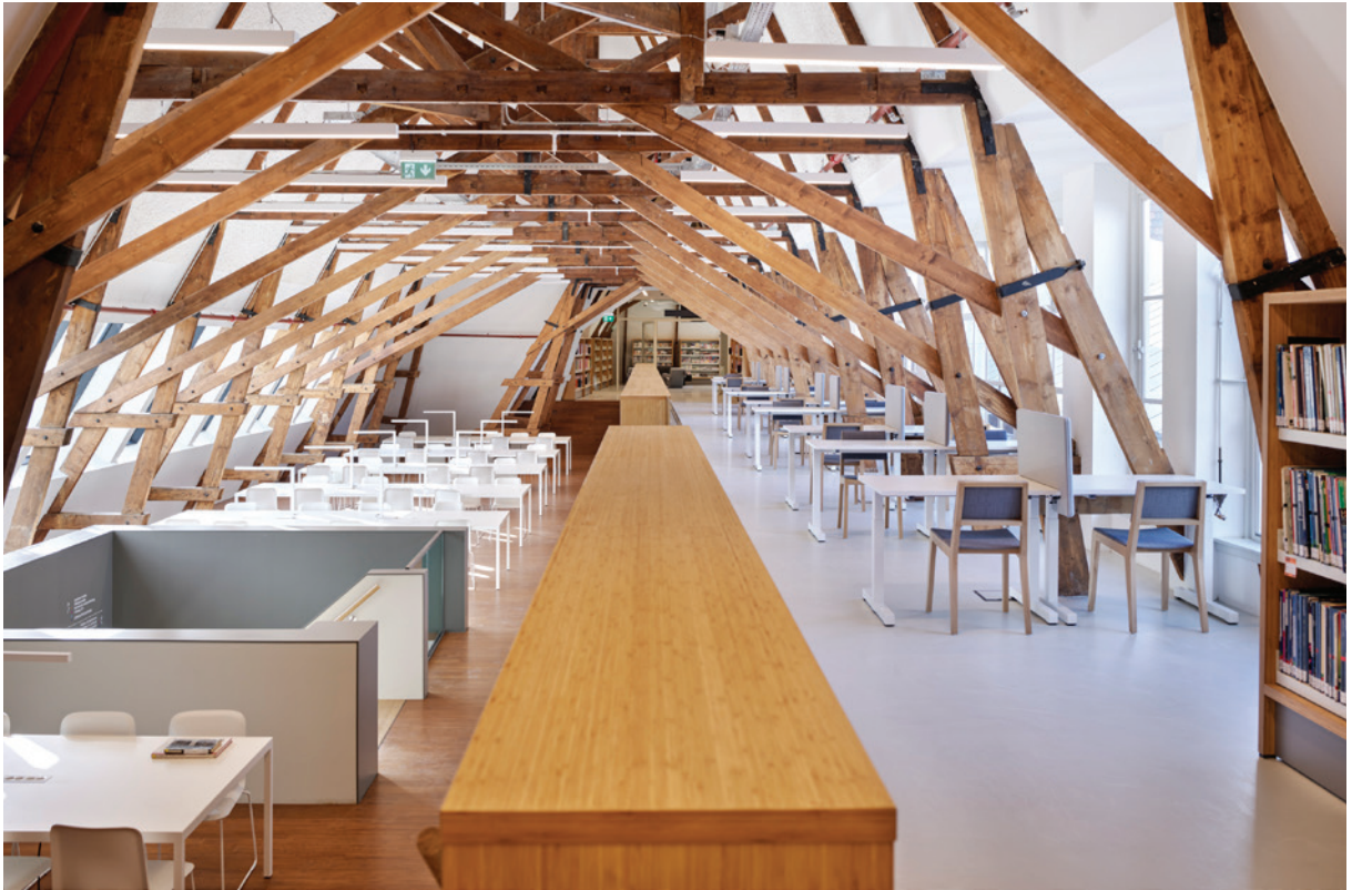
Het Stadsstudiehuis met nieuwe dakramen, door de verschillende vloerniveaus' s ontstaat er zicht naar De Neude
