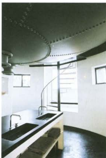
De badkamer is gepositioneerd onder de het stalen hangbodem-reservoir van 200.000 liter
