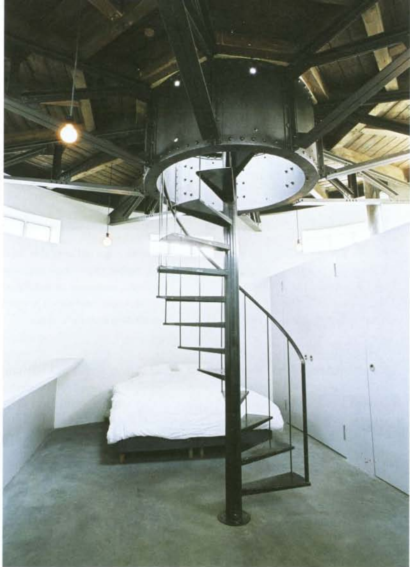
De nieuwe stalen spiltrap naar het dakterras is geplaatst in de voormalige ventilatieopening. Qua vorm, materiaal en detaillering sluit de ingreep volledig aan bij de bestaande dakconstructie
