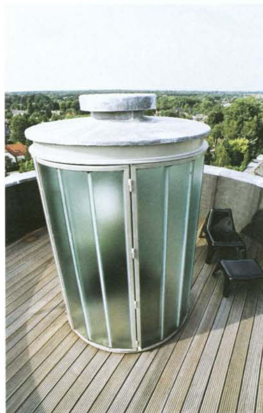
Op de plaats van de voormalige ventilatieschacht geeft een kleine opbouw van glas en staal toegang tot het fenomenale dakterras
