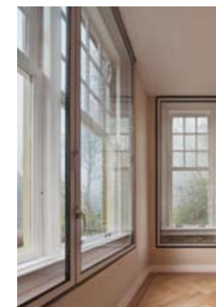
Aan de binnenzijde zijn enkele gevels van de villa voorzien van rietmatten, leemstuc, wandverwarming en isolerende achterzetbeglazing.
