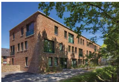
2009 Startersappartementen Amersfoort, Heijmans
