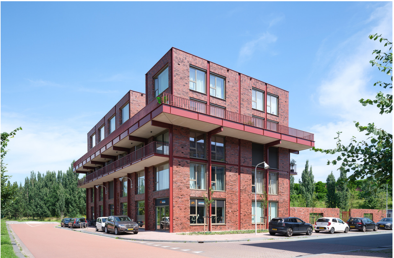
Corner view Terschellingskade / Texelstraat-noord
