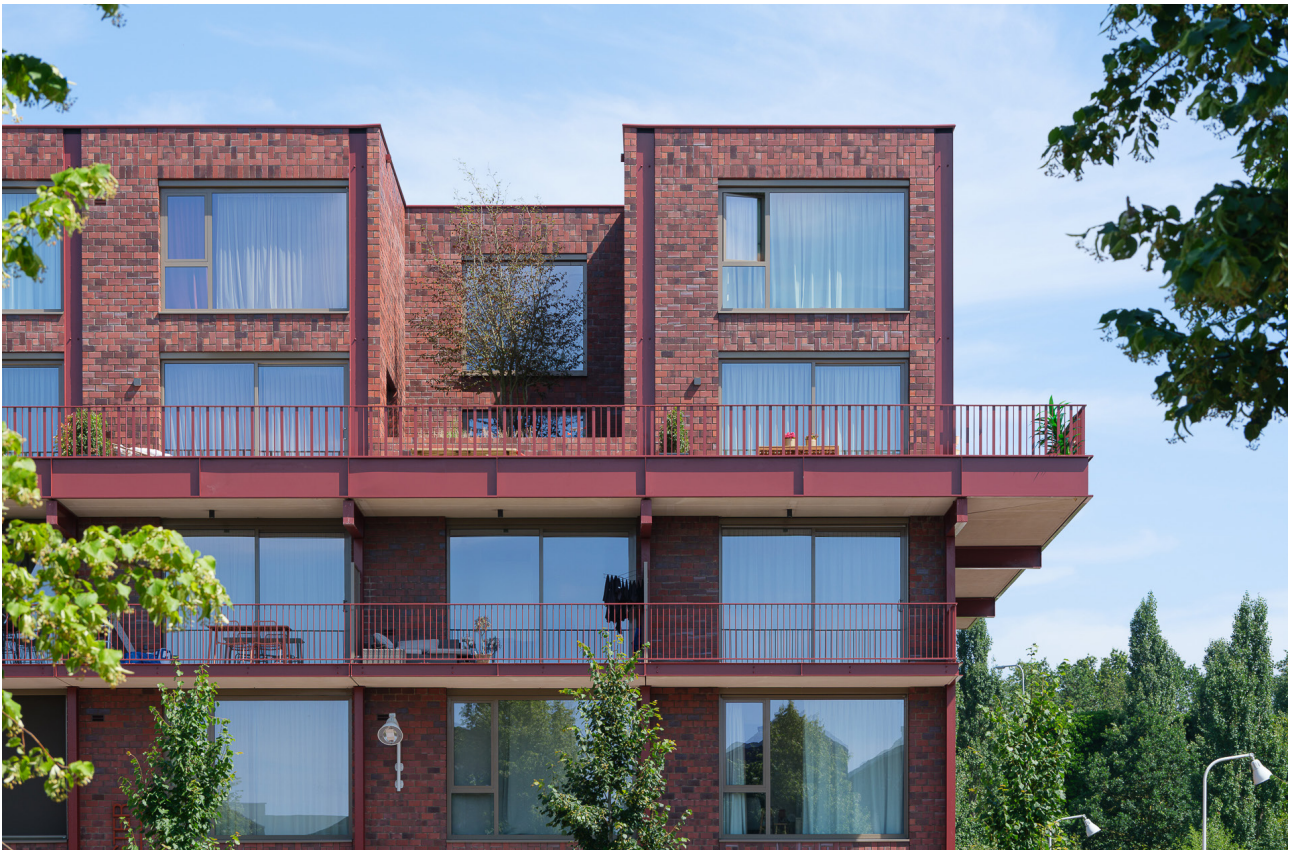
Corner view Terschellingskade / Texelstraat-noord
