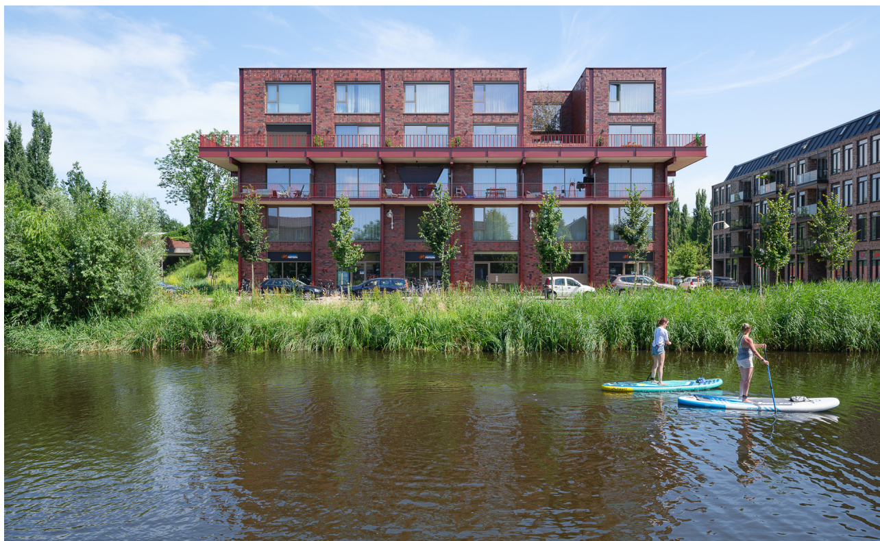
Voorgevel aan de waterloop 'laak'
